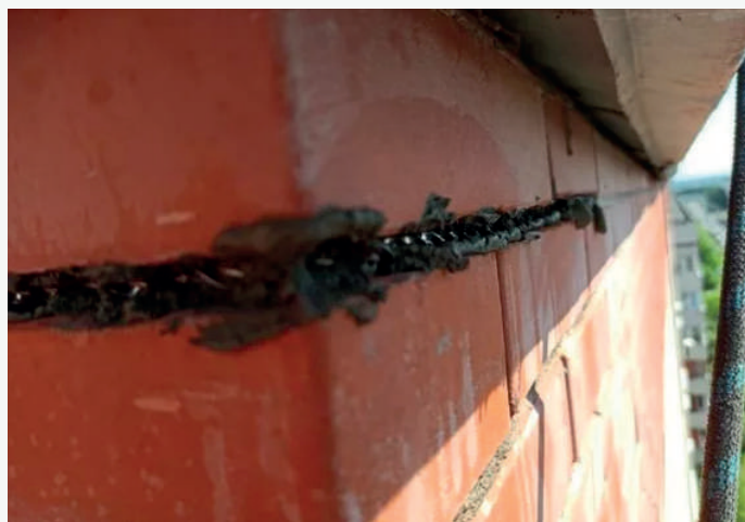
г. Санкт-Петербург, Ветеранов д. 108, Ремонт облицовки МКД
