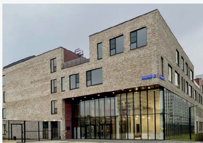
г. Москва, ул. Александры Монаховой, д. 98 А Ремонт фасада школы спиральными анкерами RSA
