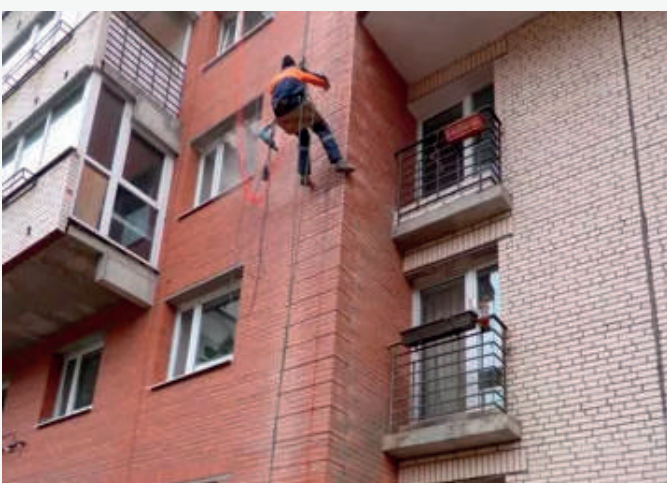
г. Санкт-Петербург, ул. Ленсовета 69 Ремонт вертикальных трещин
