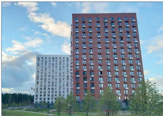
г. Москва г, Сосенское п, 7 кв-л, дом № 2, корпус 2, Ремонт облицовки МКД
